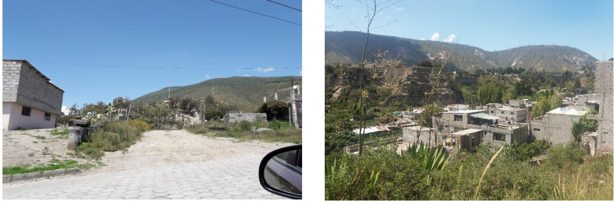
Figura 2. Proceso de autoconstrucción que se da con mucha fuerza en la periferia del norte del DMQ. Fuente: Fotos tomadas por estudiantes FAU-UTE 6to nivel año 2018.
