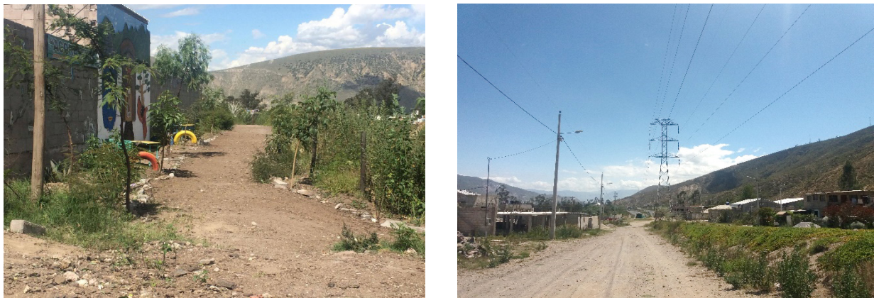
Figura 3. Calles poco definidas, sin un trazado planificado, ausencia de veredas ni recubrimientos lo que dificulta la movilidad de peatones y vehículos en la periferia del norte del DMQ. Fuente: Fotos tomadas por estudiantes FAU-UTE 6to nivel año 2018.
