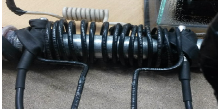
Figura 1.9. Bobina de trabajo con núcleo ferromagnético.
